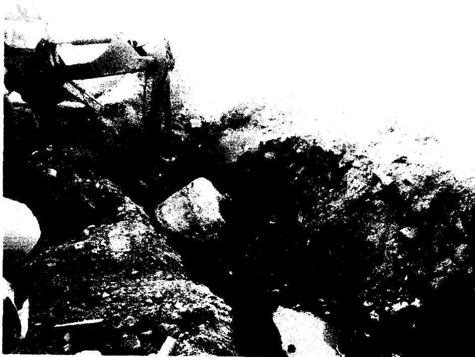
Foto N° 04: Excavación de terreno (presencia de rocas) para ubicación de Biodigestor.
